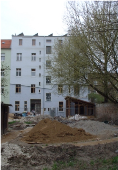
Hofansicht der Wönnichstraße 103
