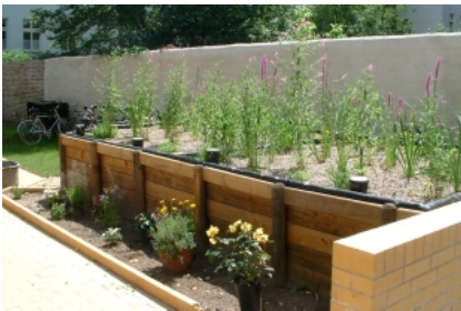
Filterbeet zur Reinigung des Grauwassers
